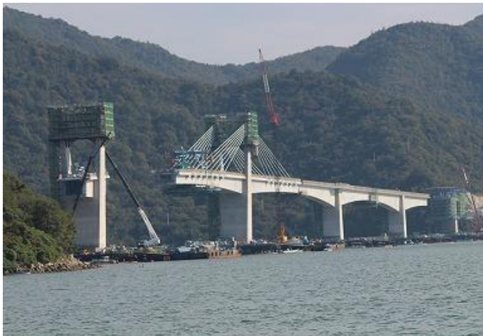
日生大橋(仮称)建設工事【備前市】
