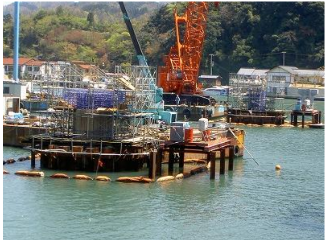
港大橋歩道橋下部工【兵庫県】
