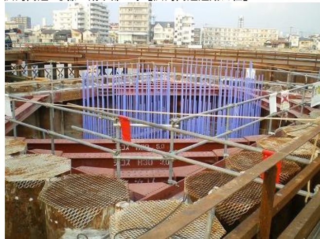
広島高速3号線二期下部工事【広島高速道路公社】
