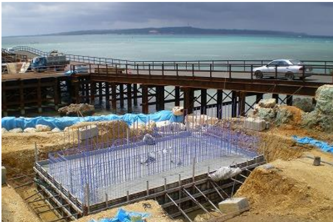
伊良部大橋橋梁整備工事(下部工)【沖縄県宮古支庁】
