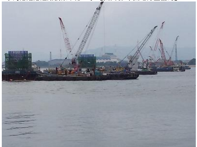
水島港臨港道路橋梁下部工事【国交省 中国地方整備局】
