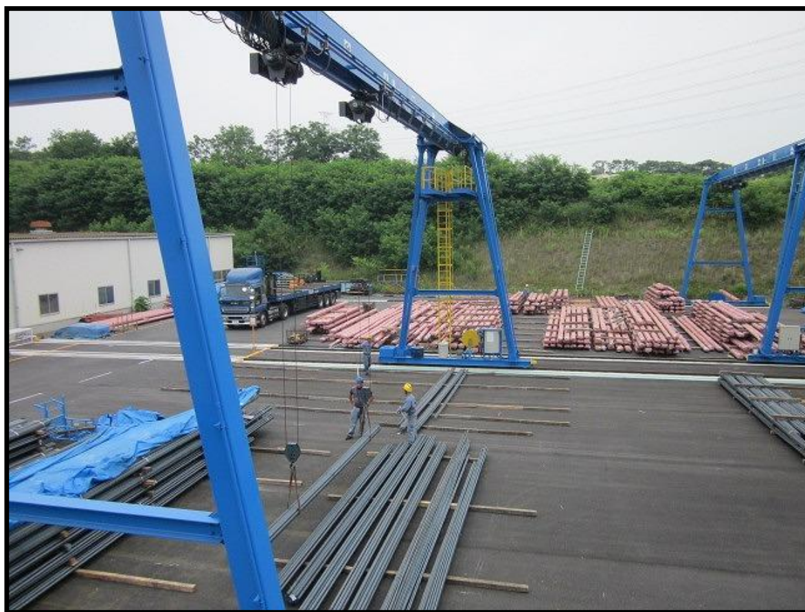
鉄筋専用保管ヤード【製品出荷・材料受入 3,000㎡】
