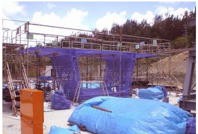
伊良部大橋橋梁整備工事(上部工)【沖縄県宮古支庁】
